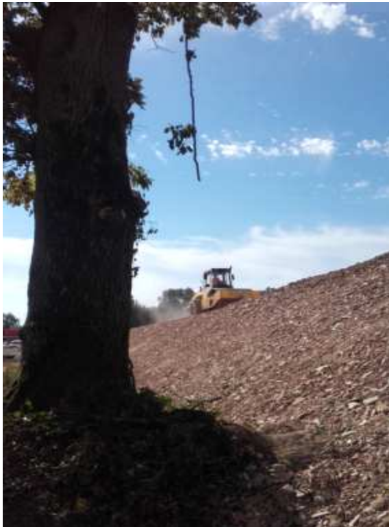
Mise en œuvre
